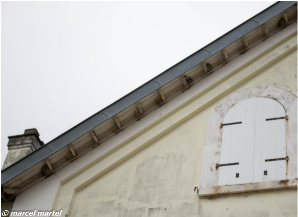
Côté gauche de la façade
